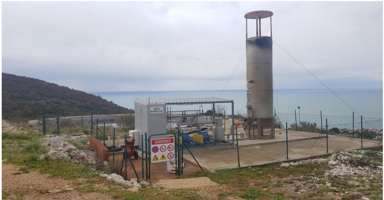
*Slika 6: Postrojenje za sagorijevanje deponijskog gasa na deponiji „Možura“*
