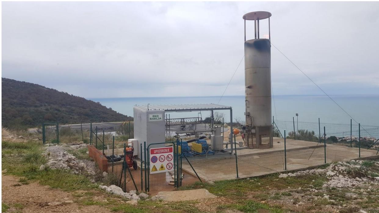
Slika 7: Postrojenje za sagorijevanje deponijskog gasa na deponiji „Možura“
