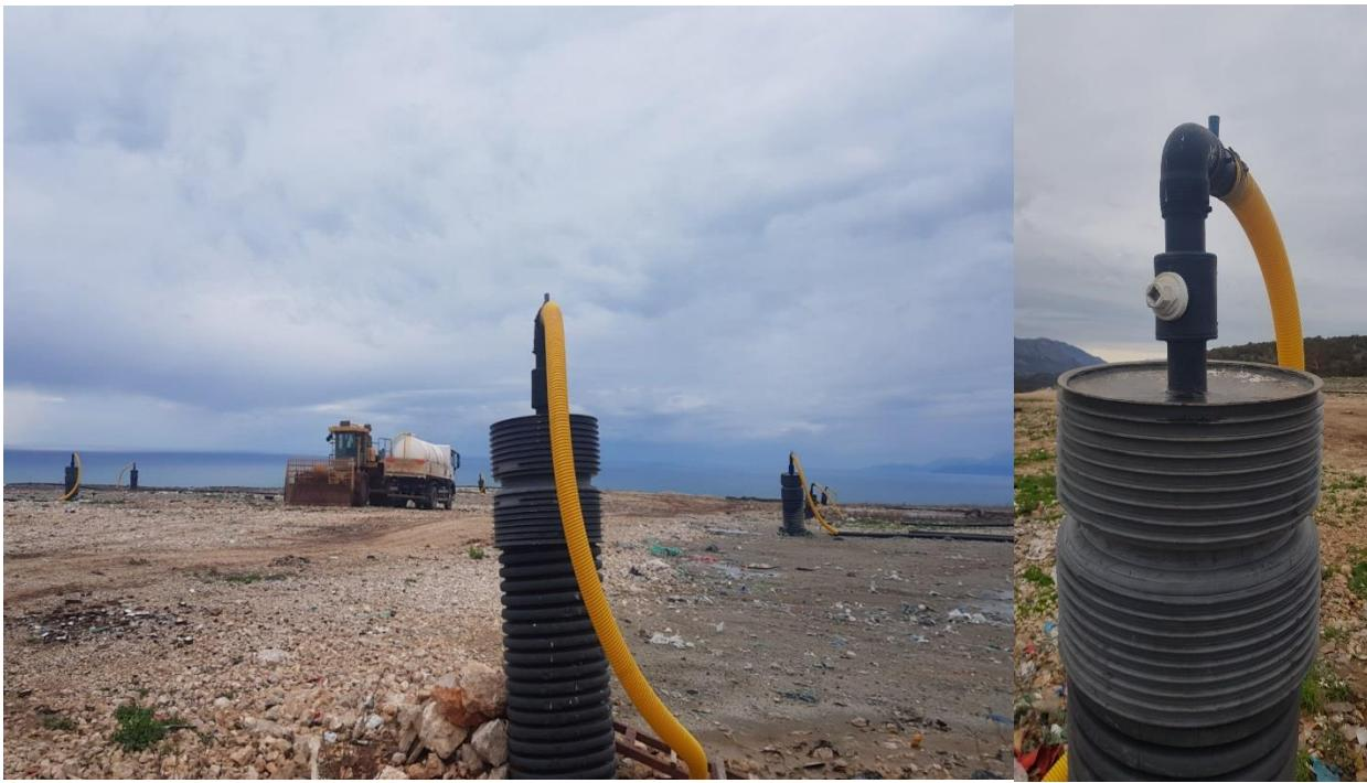
Slika 4: Biotrnovi za sakupljanje deponijskog gasa
